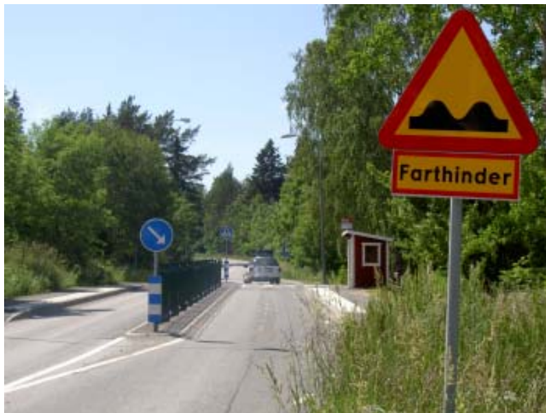
Den ombyggda hållplatsen.
